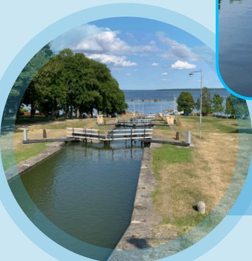
Schleusentreppe in Berg. Die größte Schleusenanlage im Götakanal mit einer Länge der Gesamtanlage von etwa einem Kilometer, nördlich von Linköping.
